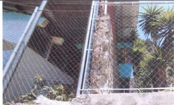
FOTO 2: Otra perspectiva de la reparación del muro perimetral
