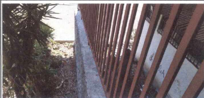
FOTO 1: Reparación de muro perimetral.
