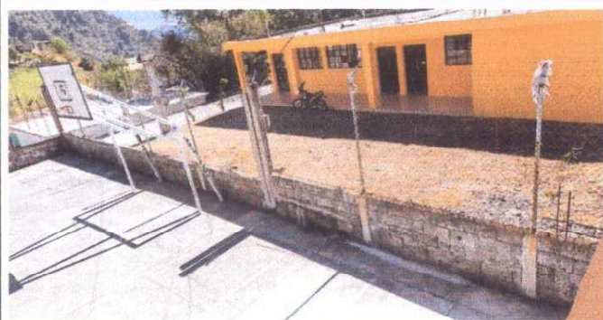
Foto 1: Reparación de muro perimetral.
