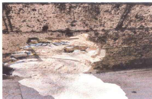
Foto 2: Reparación de muro perimetral de block.
