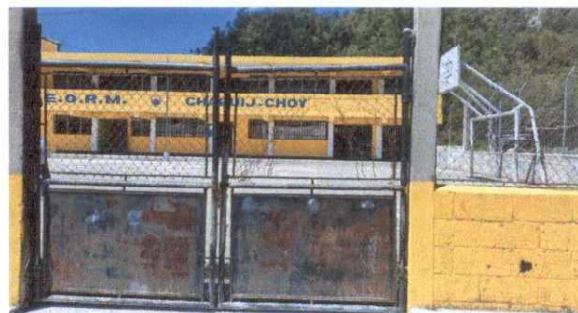
Foto 2: Mantenimiento de portones.
