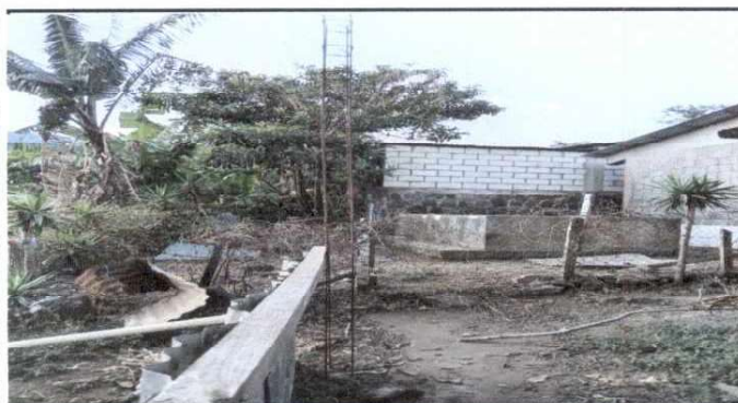
Foto 3: Circulación del lado sur en mal estado
