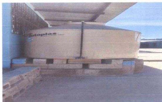
Foto 4: Instalación provisional de Tinaco
