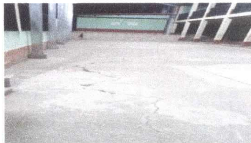
piso reparación de patio
