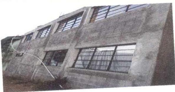
Foto 5: Reparación de rrepello y cernido de paredes
