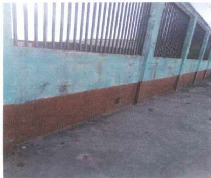
Foto 3: Se pintará el zócalo de la parte externa de la escuela.
