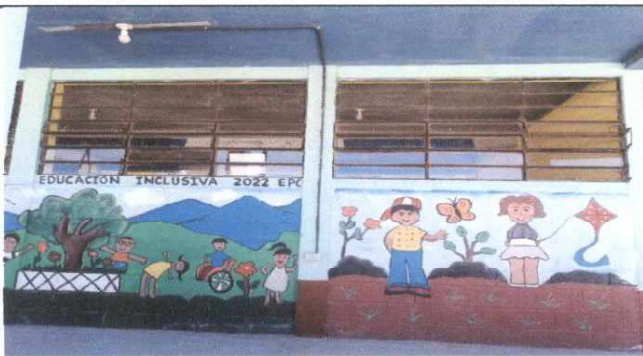
Foto 5. Se colocarán balcones a las ventanas para asegurar las pertenencias dentro del aula y evitar que se quiebren los vidrios puestos
