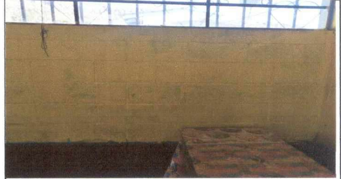
Foto 2: Pintado de toda la escuela, la parte interna
