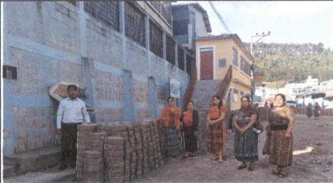
Foto1: Parte exterior de la escuela, se ve descolorido, con una impresión inadecuada para el recibimiento de los estudiantes.
