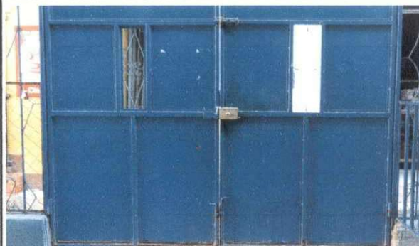
Cambio del portón entrada Norte.
