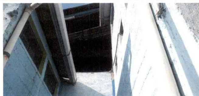
Instalación de techo por la entrada sur de la escuela
