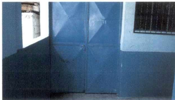
Reparación de puertas y cambio de chapas
