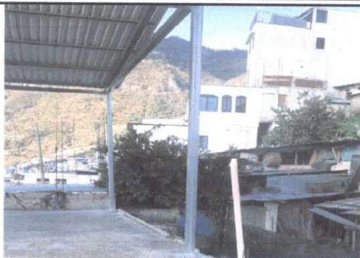
Foto 1: vista parte oriente del perímetro
