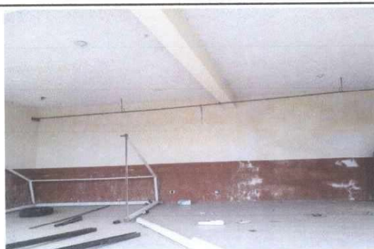
Foto 5: Se realizara nueva instalación del cableado electrico por motivo que tiene corto circuito, ademas ya los focos estan quemados, otros quebrados y otros que ya no existen
