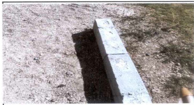
4. Extensión de pequeña parte de losa de patio
