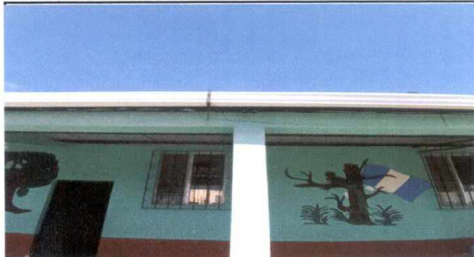
2. Reparación de cubierta de lámina
