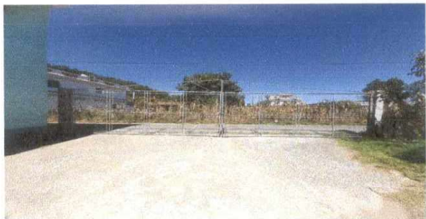
Foto 1. Se necesita mantenimiento del porton.
