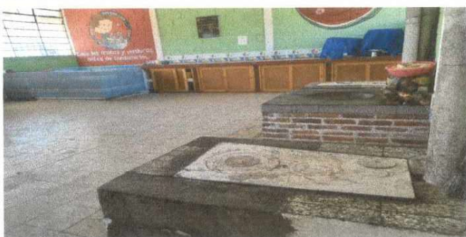
Foto 3. Se necesita reparacion de la cocina.
