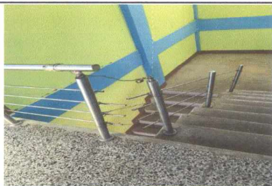
Foto 3: Mantenimiento de barandas por encontrarse en malas condiciones y evitar el peligro de ingreso y egreso de los niños en el segundo nivel.
