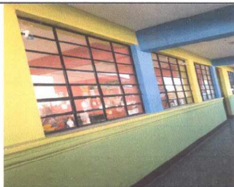
Foto 4: Colocación de Balcones para proteger la seguridad del aula que se usa como laboratorio de computación.
