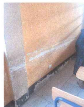
Foto 4: En la fotografía se puede observar el mal estado en el que se encuentran los acabados de repello en paredes. Por eso se aplicará repello nuevo a las zonas desprendidas.
