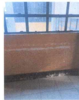
Foto 4: En la fotografía se puede observar el mal estado en el que se encuentran los acabados de repello en paredes. Por eso se aplicará repello nuevo a las zonas desprendidas.
