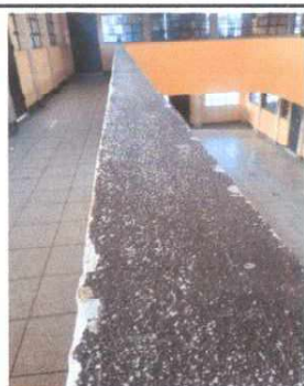
Foto 5: En la fotografía se puede observar el mal estado en el que se encuentran los acabados de repello en paredes. Por eso se aplicará repello nuevo a las zonas desprendidas.
