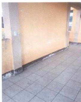
Foto 3: En la fotografía se puede observar el mal estado en el que se encuentran los acabados de repello en las paredes. Por eso se aplicará repello nuevo a las zonas desprendidas.
