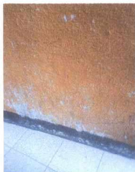
Foto 3: En la fotografía se puede observar el mal estado en el que se encuentran los acabados de repello en las paredes. Por eso se aplicará repello nuevo a las zonas desprendidas.
