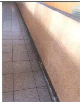
Foto 5: En la fotografía se puede observar el mal estado en el que se encuentran los acabados de repello en paredes. Por eso se aplicará repello nuevo a las zonas desprendidas.
