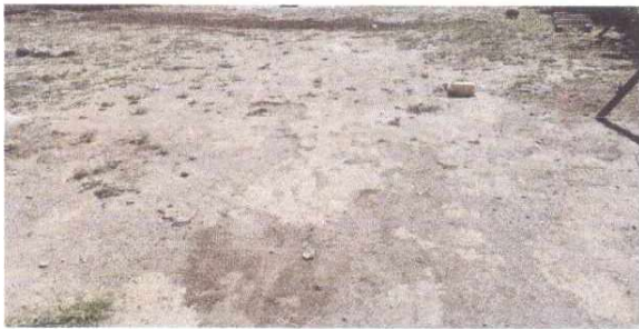
Foto 3. Se ampliará el arreglo de patio con piso de cemento
