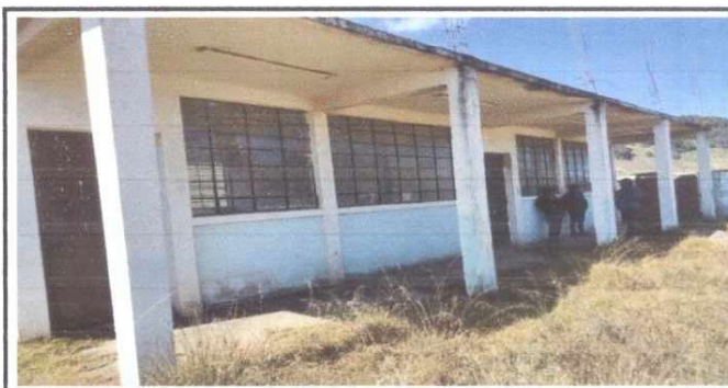
Foto 6: SUMINISTRO Y APLICACIÓN DE 152.00 Mts2; DE PINTURA EN MUROS INTERNOS Y EXTERNOS, MÓDULO "B". (UN SALÓN DE CLASES).
