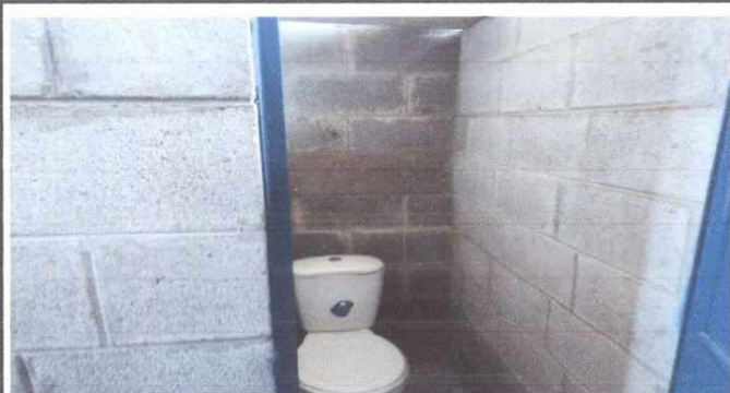
Foto1: SUMINISTRO E INSTALACIÓN DE AZULEJO EN LAS PAREDES DE LOS MÓDULOS DE SERVICIOS SANITARIOS, (HOMBRES Y MUJERES).
