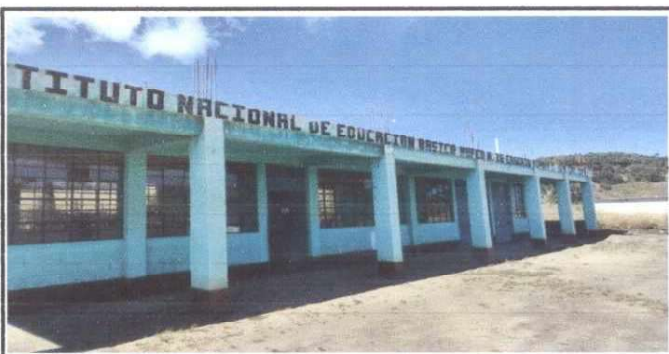
Foto 5: SUMINISTRO Y APLICACIÓN DE PINTURA EN MUROS INTERNOS Y EXTERNOS, A DOS MANOS DE APLICACIÓN
