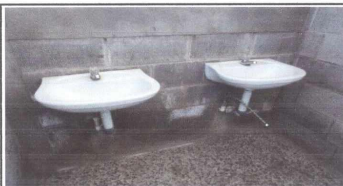
Foto 3: SUMINISTRO Y CAMBIO DE KITS DE ACCESORIOS DE DOS UNIDADES DE LAVAMANOS, EN EL MÓDULO DE SERVICIOS SANITARIOS MUJERES.
