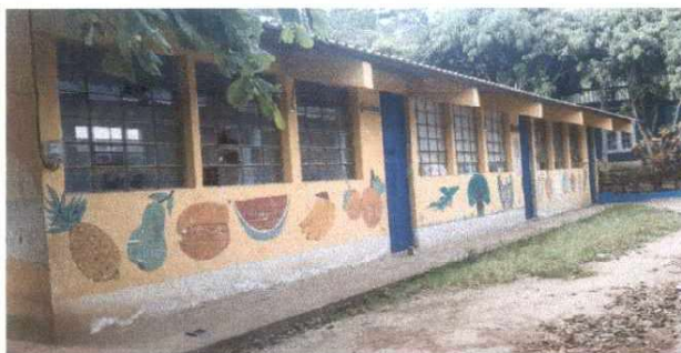
FOTO 10: Suministro e instalación de balcones de metal modulo 5
