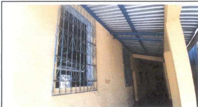
FOTO 7: Suministro e instalación de balcones de metal modulo 3
