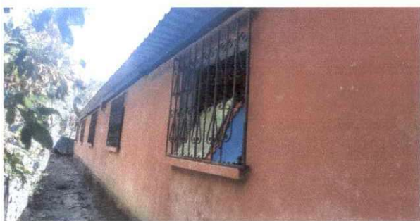
FOTO 9: Suministro e instalación de balcones de metal modulo 4 atras
