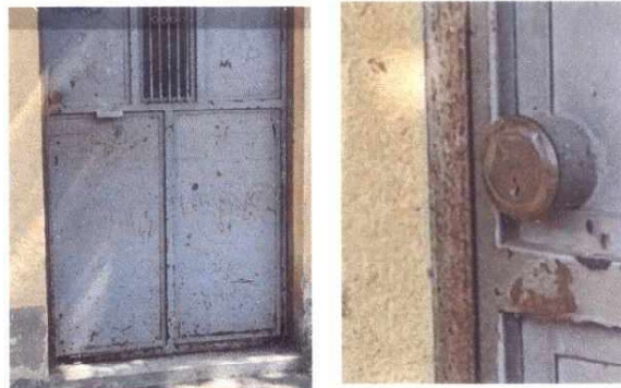
FOTO. 2: MANTENIMIENTO A ESTRUCTURA Y PINTURA DE PUERTAS
