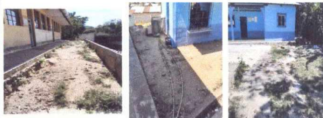
Foto 4: REPARACIÓN DE LOSA EN MAL ESTADO.
