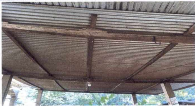
Foto 1: Cubierta de lámina (Cambio de láminas deteriorado)
