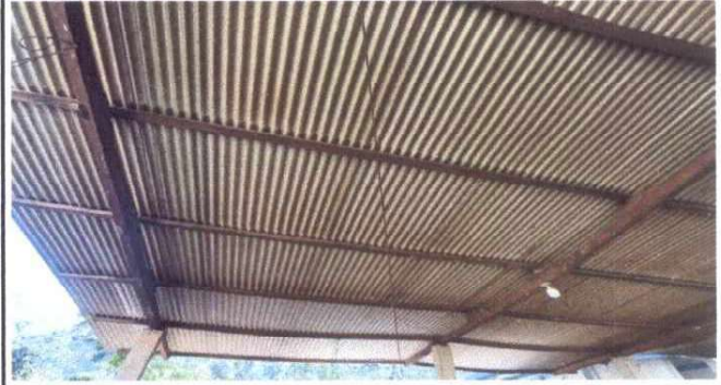
foto 2: Cubierta de lámina (cambio de estructura de techo deteriorado)
