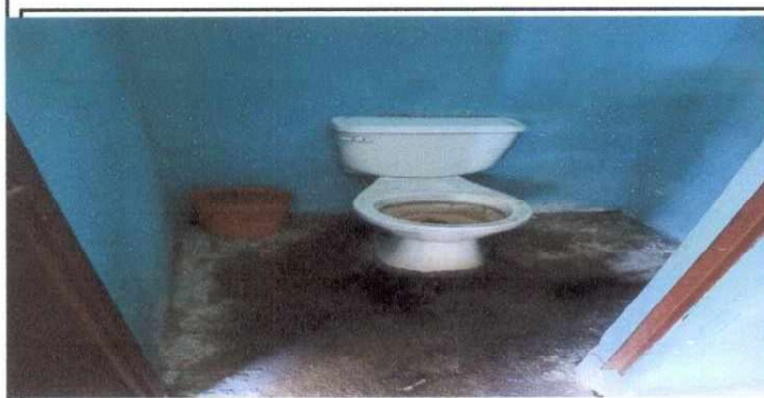
Foto 5: Baños a reparar
