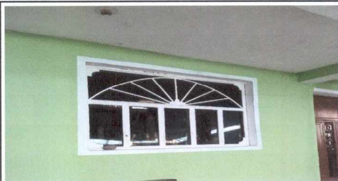
Foto1: Venta sin balcon.
