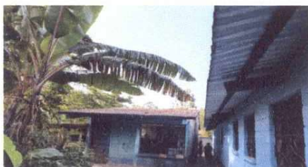
FOTO 3 CAMBIO DE LAMINAS EN MAL ESTADO
