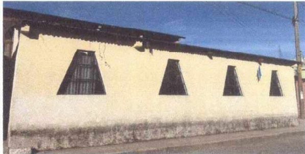
Foto 4: Pintada de paredes
