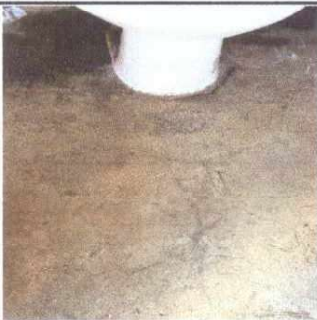
Foto 5: Sustitución de piso de concreto
