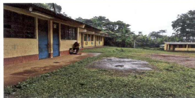
FOTO. 3 ACUMULACION DE AGUA EN EL PATIO DE LA ESCUELA PONE EN RIESGO ALOS ESTUDIANTES EN TIEMPOS DE INIVIERNO.
