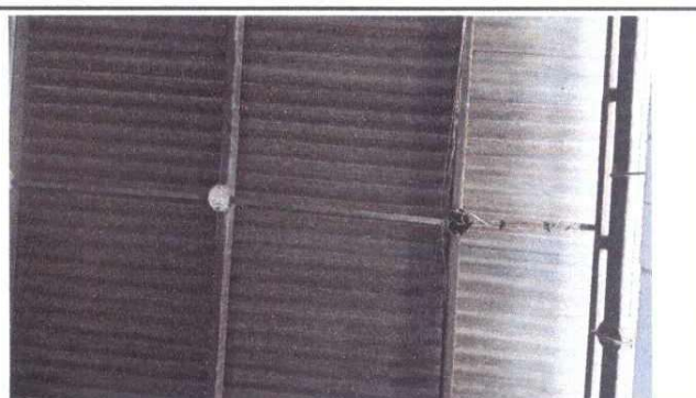
Foto 4. Sistema eléctrico deteriorado
