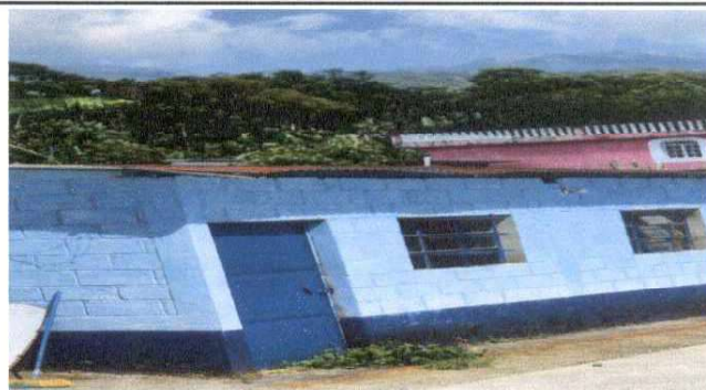
Foto 2: Cubierta de lámina (mejoramiento de corredor)
