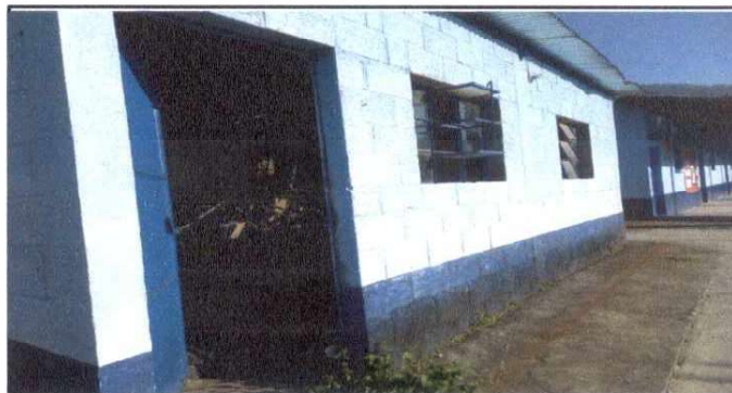
Foto 4: Cubierta de lámina (mejoramiento de corredor)
