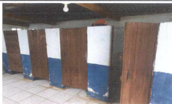
Foto 2: Sustrucion de 5 puertas de servicio sanitario
