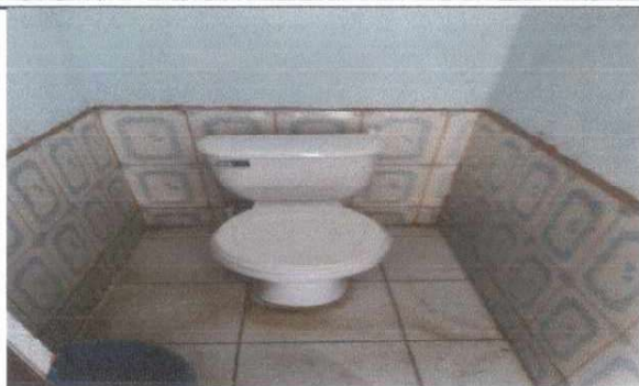
Foto1: Sustrucion de 5 inodoro
