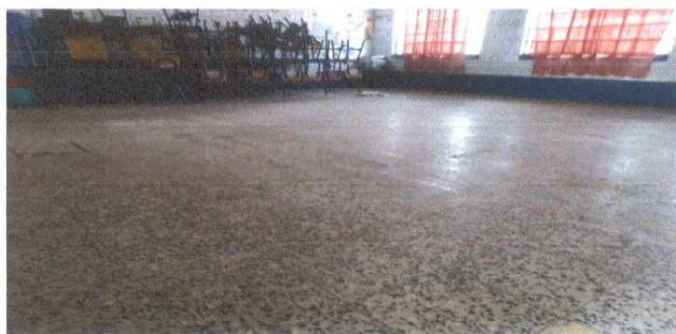
Foto 3: Sustrucion de piso de 3 aulas de 7x7
