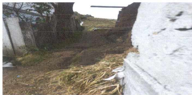
Foto 5: Reparación de muro de contención
