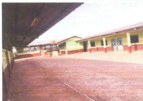
FOTO 3: MEJORAMIENTO DEL TECHADO
