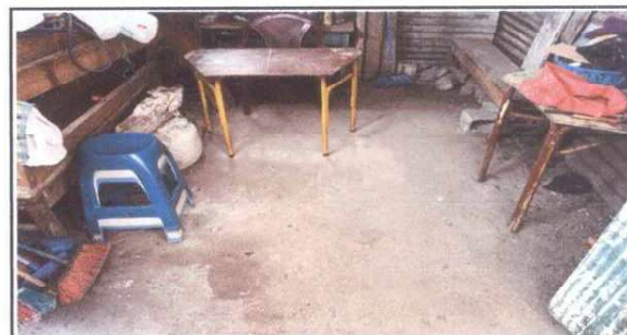
Foto 4: Piso de tierra.
