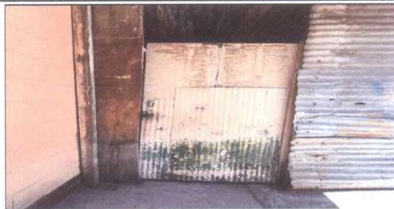
Foto 2: Puerta de entrada con lámina.
