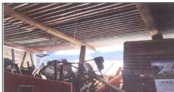
Foto 3: Columnas regias de maderas.
