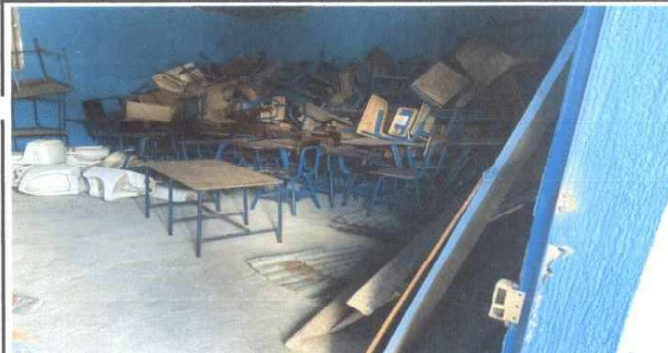
SUSTITUCION DE PISO CERAMICO
