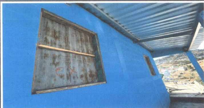
SUSTITUCION DE VENTANAS DE MADERA
