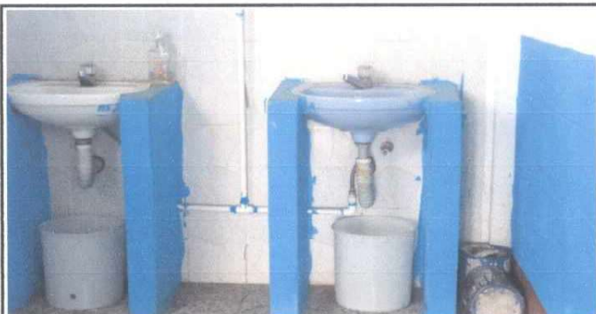
SUSTITUCION DE MEZCLADORA LAVAMANOS (con llave, tubo de abasto)
