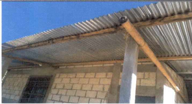
Foto 1: Sustrucción de cubierta de lámina y estructura de techo
