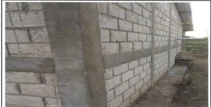
Foto 6: Reparación de repello y cernido de paredes
