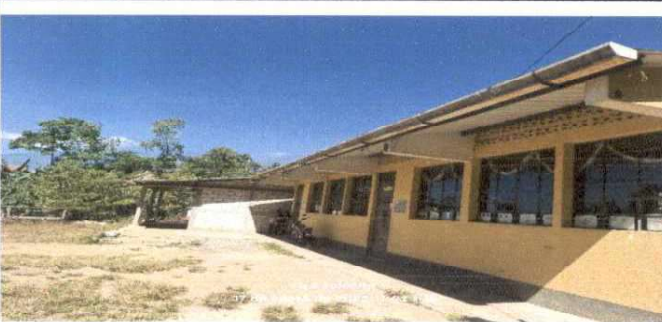
Foto 5: Losa de patio
