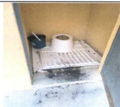
Foto 4: Reparación de servicios sanitarios
