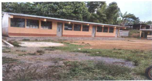
FOTO. 3 ACUMULACION DE AGUA EN EL PATIO DE LA ESCUELA PONE EN RIESGO ALOS ESTUDIANTES EN TIEMPOS DE INVIERNO
