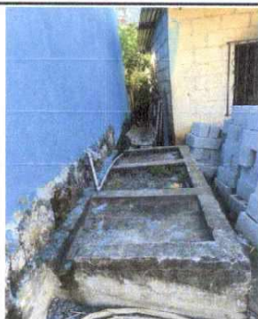
Foto 7: Reparación de red de drenajes para evitar focos de contaminación
