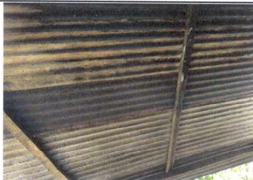
Foto 2: Sustitución de estructura de techo de madera por costaneras
