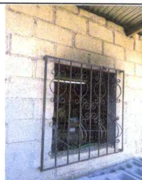
Foto 4: Mantenimiento e instalación de balcones de 1.20*1.20 mts
