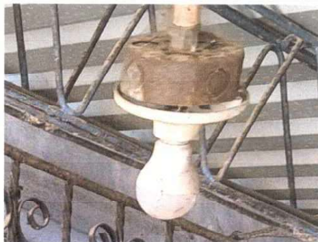
Foto 8: Reparación de sistema eléctrico
