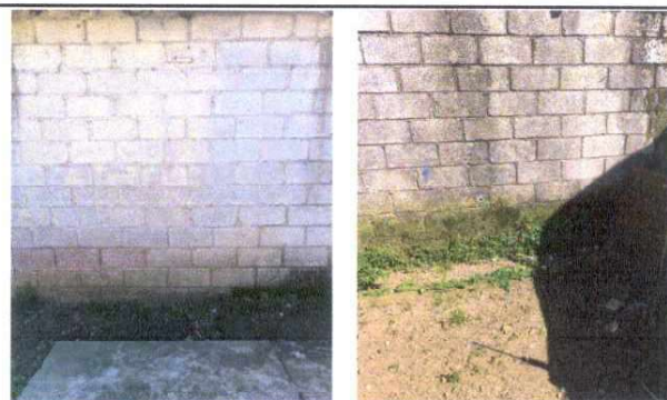
Foto 10: Reparación de repello y cernido de paredes
