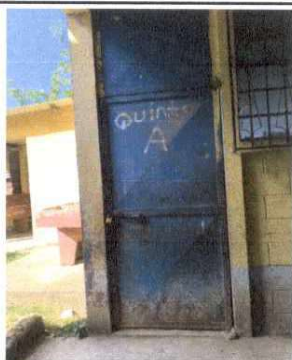
Foto 3: Suministro e instalación de puerta principal de metal 1m * 2.10m
