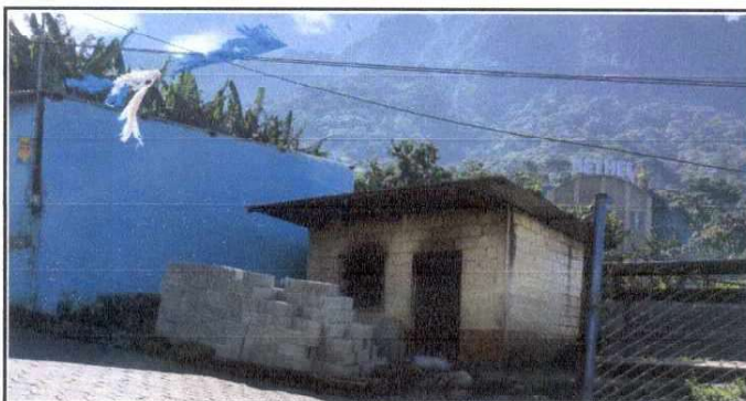
Foto 9: Reparación de ambiente de cocina para la preparación de la Alimentación Escolar
