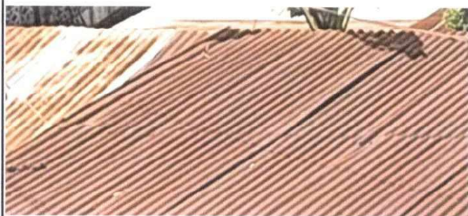
Foto 1: Sustitución de cubierta de lámina por lámina troqueleada calibre 26 de 22 ft
