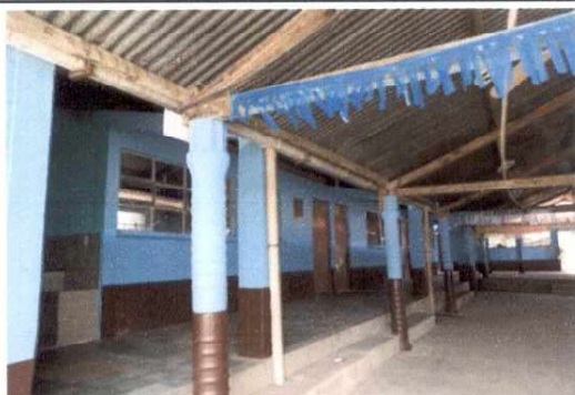
Foto 3: Reparación de columnas de soporte de estructura metalica de techo
