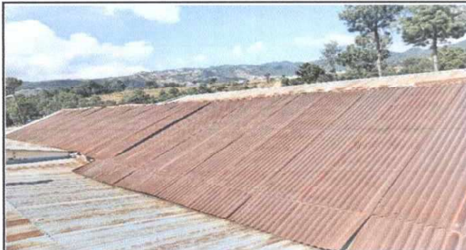
Foto 2: Sustitución de lámina por lamina troquelada aluzinik calibre 26
