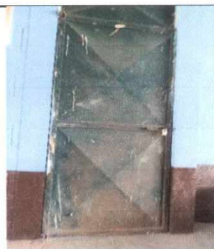
Foto 6: Mantenimiento de 9 puertas y aplicación de pintura
