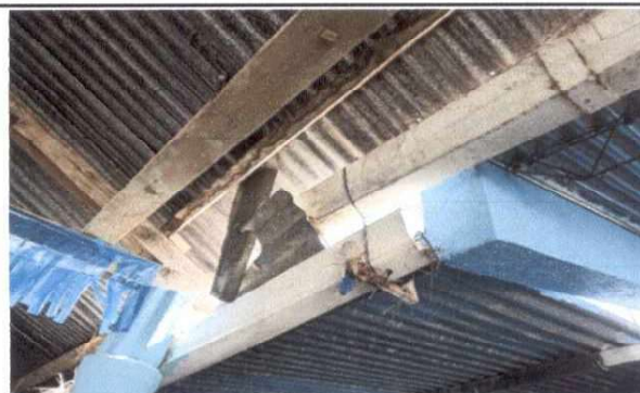
Foto 4: Sustitución de canal y bajadas pluviales tubo pvc
