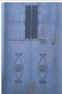
Foto 3: Ampliación y sustitución de puertas
