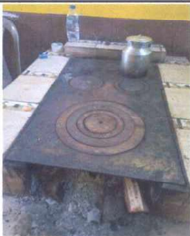
Foto 7: Reparacion y sustitucion de areas de cocina.
