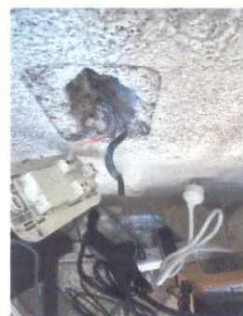
Foto 6: Reparación del sistema eléctrico
