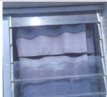
Foto 4: Reparacion y sustitucion de ventanas
