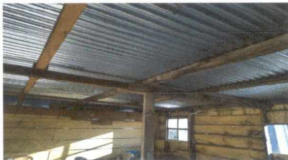
Foto 3: Estructura de techo
