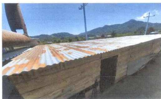
Foto 2: Cubierta de Lámina (Lado izquierdo)
