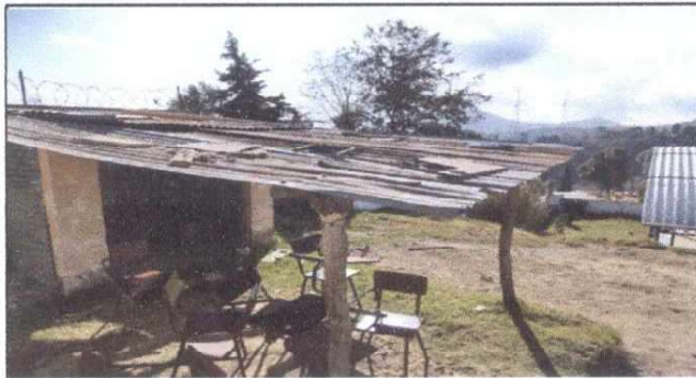
Foto1: Mejoramiento de Cubierta de Lámina: Sustitución por lamina troquelada calibre 26
