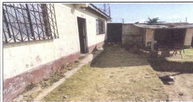
Foto 9: Losa de patio, pavimentación enfrente de la cocina.
