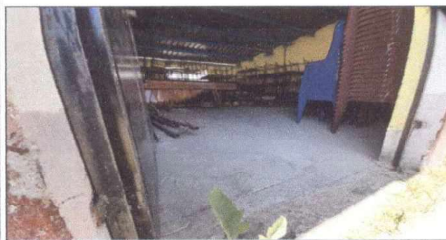
Foto 5: Piso, colocación de piso en el area de cocina.
