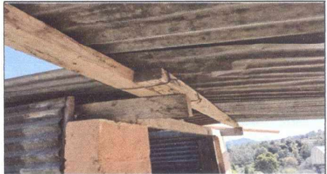
Foto 2: Estructura de techo.
