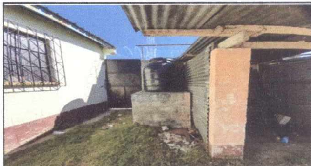
Foto 10: Reparación y mantenimiento de cisterna/depositos de agua, sustitución de ROTOPLAS y mejoramiento de base.
