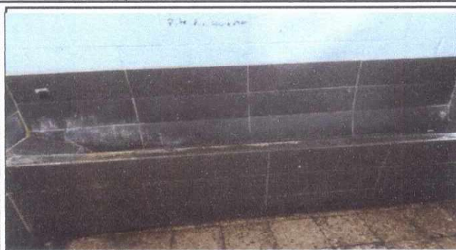
Foto 7: Servicios sanitarios y sus accesorios, mejoramiento de mingitorio para varones.
