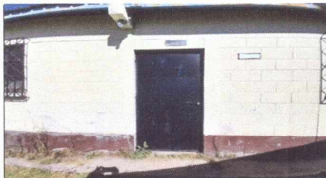
Foto 3: Puerta, Sustitucion de Puerta.
