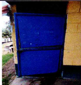
Foto 4: Sustitución de la puerta del migitoio
