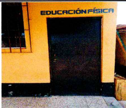
Foto 3: Cambio de puerta de madera por de metal con chapa
