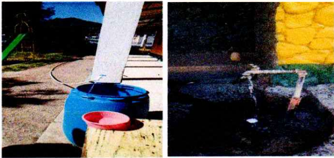
Foto1: Cambio de la tubería del sistema de agua
