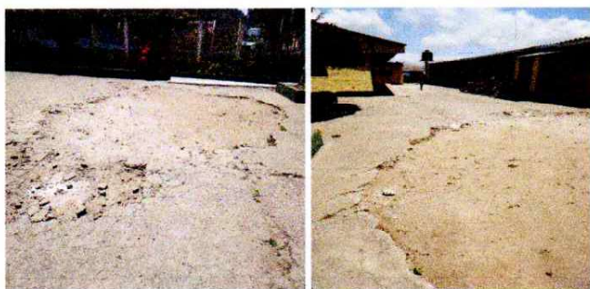
Foto 5: Reparación de los patios de la escuela
