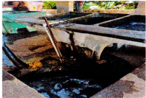
Foto 2: Reparación del sistema de agua
