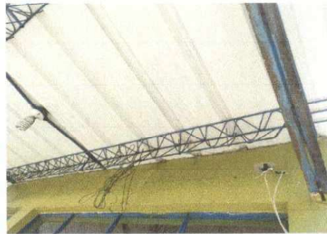
Foto 2: ESTRUCTURA DE TECHO: sustitución de toda la estructura del techo oxidado.
