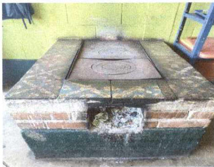
Foto 3: REPARACION O SUSTITUCIÓN DE AREA DE COCINA: Desmantelación y construcción de dos planchas nuevas
