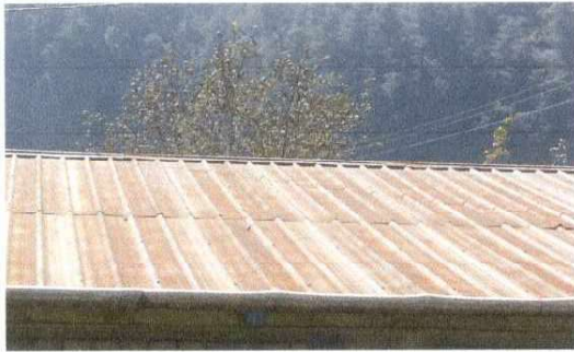
Foto1: CUBIERTA DE LAMINA: Sustitución de laminas dañadas y deterioradas por su antigüedad
