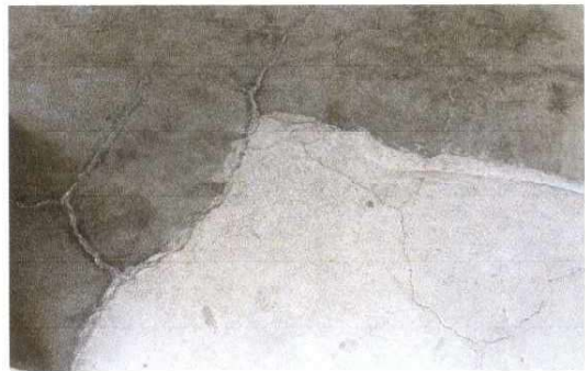
Foto 4: PISO: Levantado del alisado de cemento actual y colocación de piso cerámico
