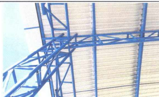
Foto 6: Ampleación e instalación de energía eléctrica en cancha polideportiva que se utilizará como salón de la escuela
