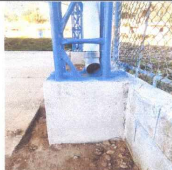
Foto 4: Red de drenaje al rededor de toda la cancha.
