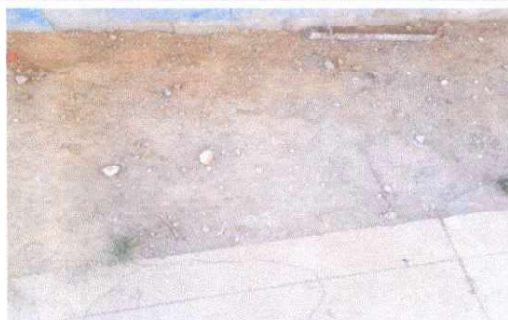
Foto 5: losa de partio para mejor las instalaciones
