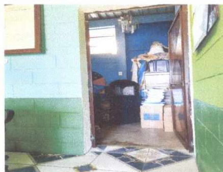
Foto 2: Instalación de cerámica en un ambiente y ampliación.
