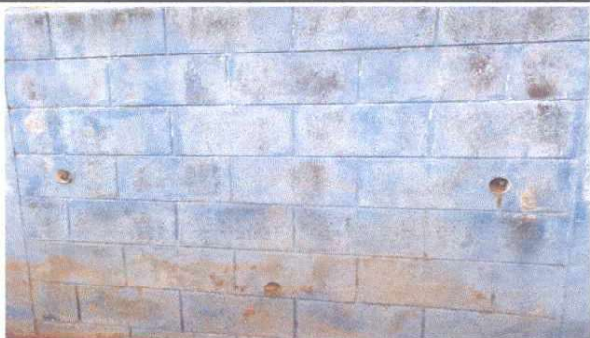
Foto 3: Pintada de muro exterior
