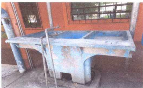
Foto 7: Sustitución de pila
