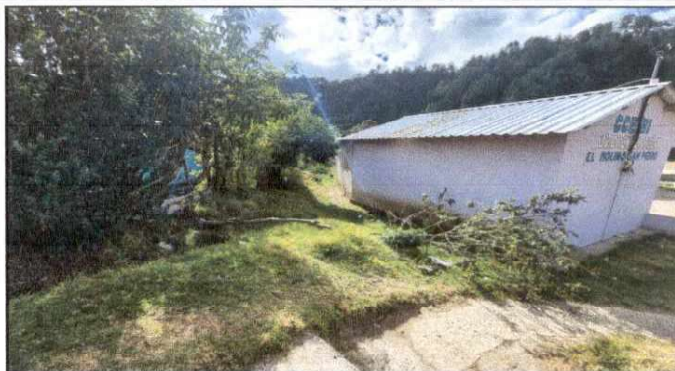
Foto 2: Implementacion de muro perimetral de block y malla
