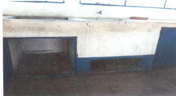
Foto 2. REPARACIÓN DE RED DE DRENAJES Y RED DE AGUA POTABLE, COLOCACION DE TUBOS EN LA PILA
