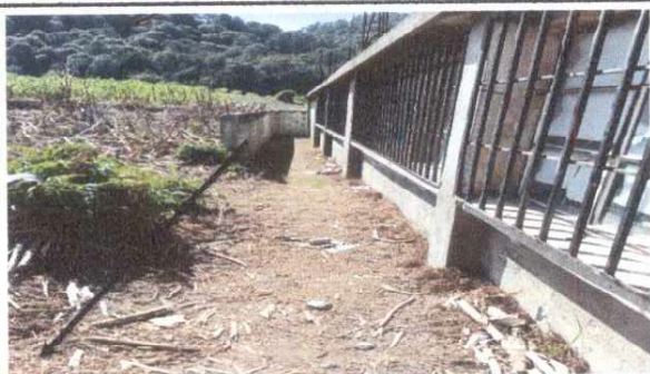
Foto 3. CERCO O MURO PERIMETRAL DETRÁS DE LAS AULAS
