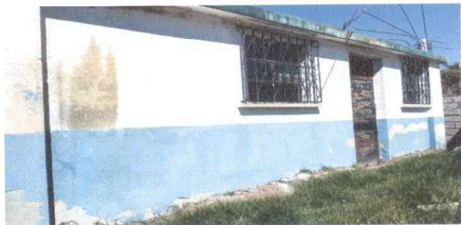
Foto1: PINTURA EN MUROS INTERIOR Y EXTERIOR, PINTAR PAREDES EXTERIORES DE LA ESCUELA Y COCINA POR DETERIORO.
