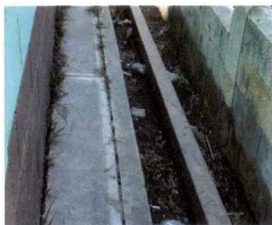
Foto 5: Se necesita hacer una fundicion de Cuneta de concreto , actualmente este espacio es donde pasa el agua que sale de la pila y de los lavamanos, se llena de lodo.
