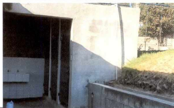
Foto 12 : pintar los baños interior y exterior
