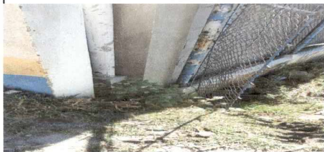
Foto 7: Es necesario soldar el marco de maya perimetral.
