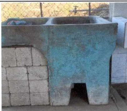
Foto 3. Se muestra la pila la cual sera reemplazada por nueva
