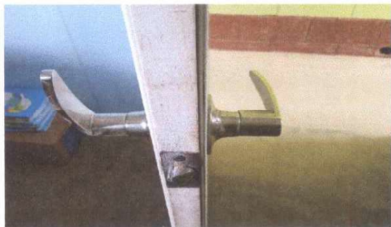
Foto 1: Puertas: Sustitución de chapa descompuesta.
