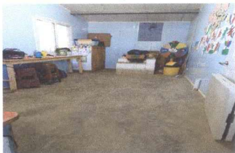
Foto 3: Piso: colocación de piso cerámico en un aula con base de cemento
