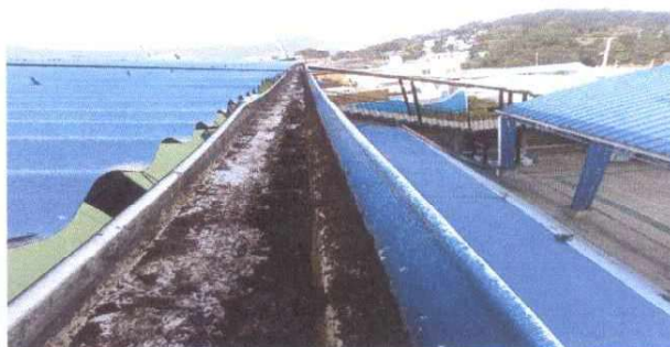
Foto 4: Canales y bajadas de agua pluvial: Sustitución de las existentes deterioradas e instaladas desde hace 27 años
