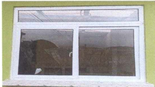
Foto 2: ventanas: sustitución de ventanas quebradas
