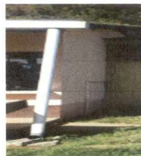
Foto 6: Canales y bajadas de agua: Implementación de canales y tubería de PVC para bajadas de aguas pluviales.
