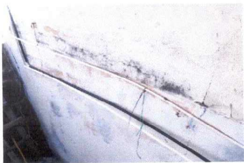
FOTO 7 Reparación de red de drenajes y red de agua potable.
