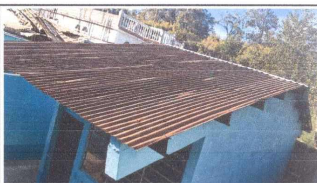
Foto 4: Se removerá la lámina, en su lugar se instalará lámina troquelada, calibre 26, ampliando la cobertura en un pasillo de 1.5 m.
