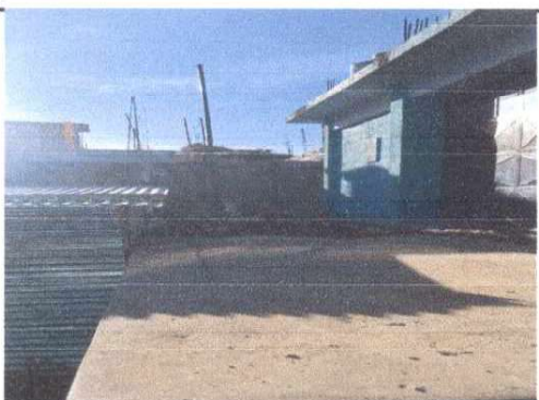
Foto 3: Se instalará barandas frente al salón Escolar que está a una altura de 2m.
