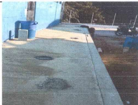
Foto 2: Se instalará barandas frente a 2 aulas 1.6m de altura.
