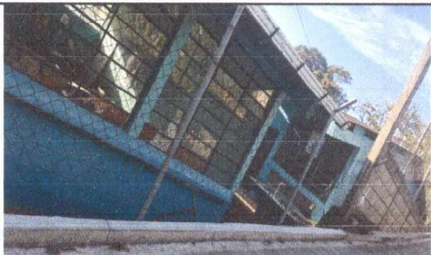
Foto 1: Se removerá la malla metálica, en su lugar se instalará muro de block.
