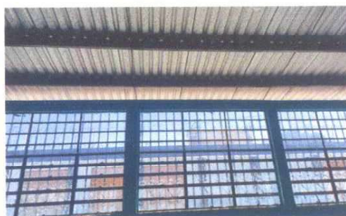
Foto 4: Paredes de muros con espacio
