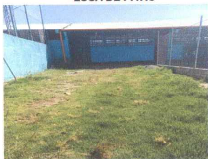
Foto 5: Complementación de losa de patio
