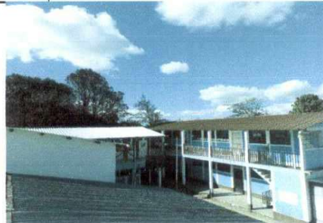
Foto 2: Colocacion de lamina y estructuracion de techo del lugar civico de la escuela.
