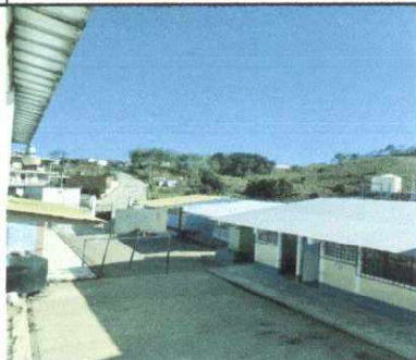
Foto1: Colocacion de lamina y estructuracion de techo del lugar civico de la escuela.
