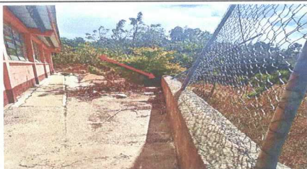
Foto 1: Lado poniente del muro ya construido, falta completar el lado oriente.
