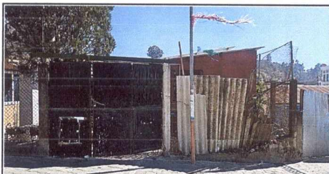
Foto 3: Vista del espacio que necesita con urgencia un Muro Perimetral de Block, para garantizar la seguridad del edificio escolar.
