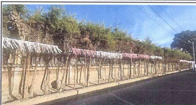
Foto 2: Vista Muro Perimetral de Malla lado oeste de la escuela, que ya se encuentra en mal estado debido a los años de uso.
