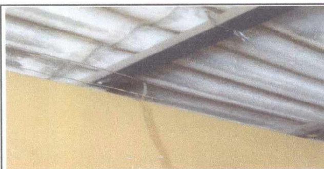
Foto 5: Reparación de sistema eléctrico sin funcionar
