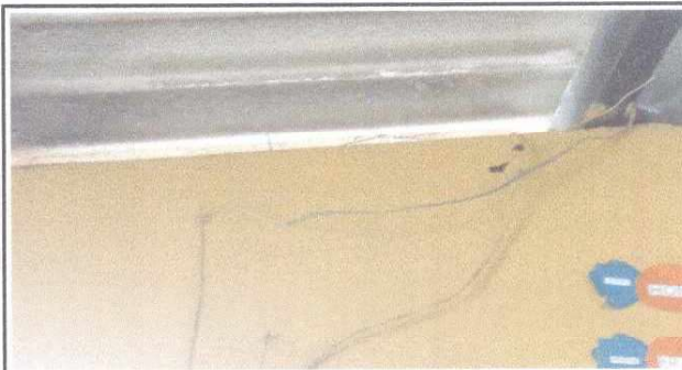
Foto 4: Reparación de sistema eléctrico en mal estado
